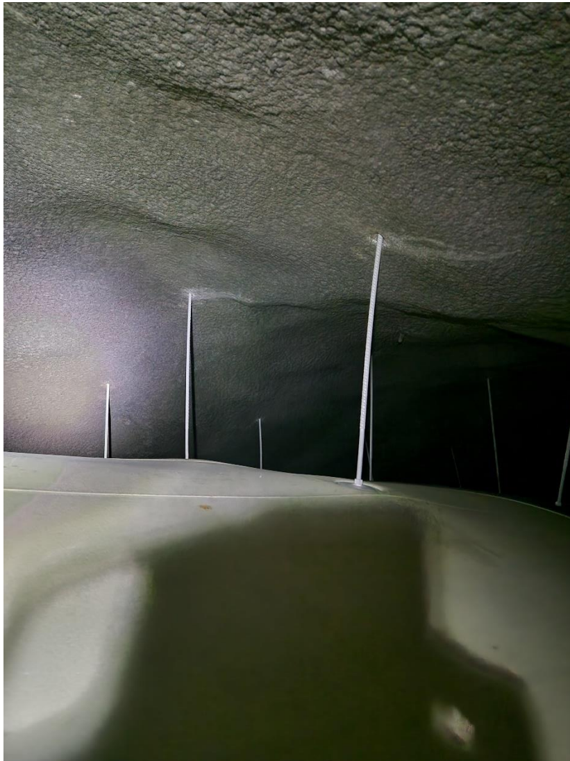
Figur 2. Eksempelbilde av henget høyre side Pel 1030–1060. Det er få til ingen observerte riss i henget.
