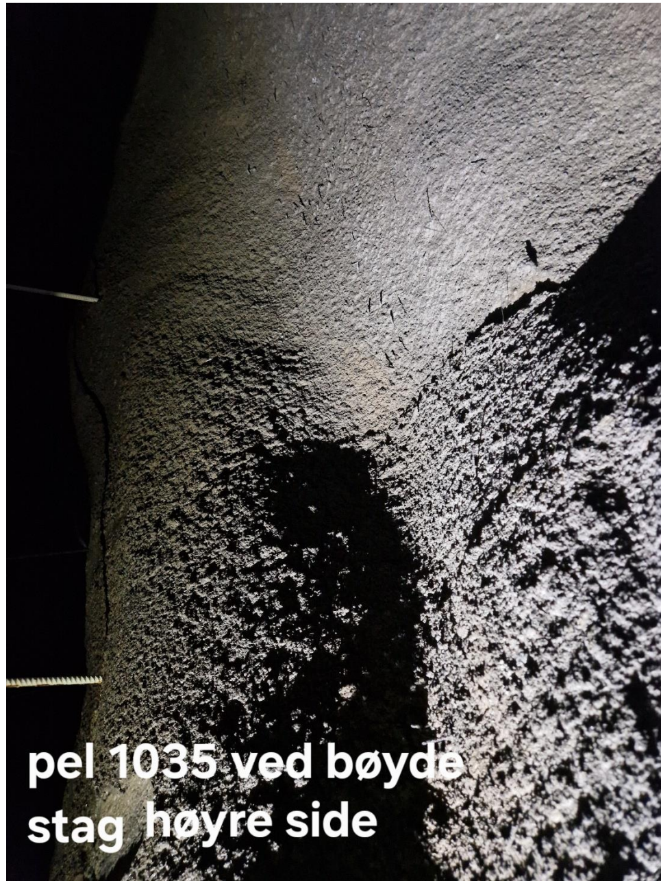
Figur 4. Banket bom på et begrenset område i sprøytebetongen. Side til vederlag høyre side.
