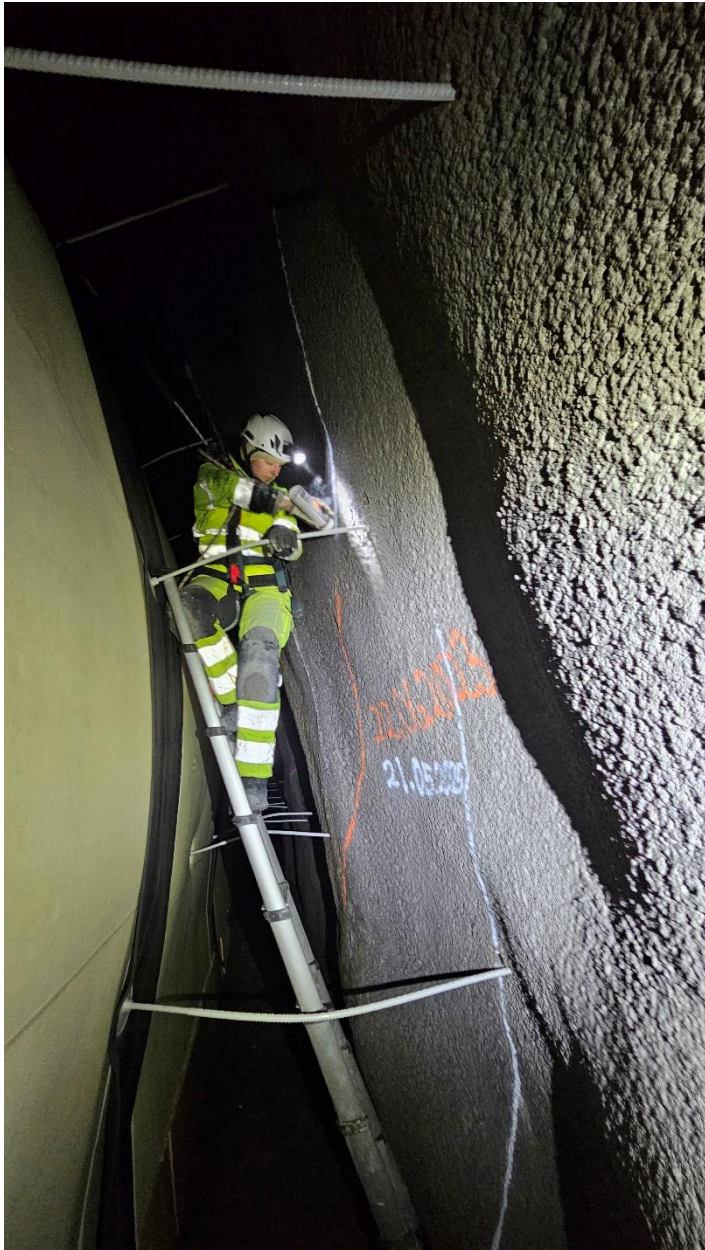
Figur 8. Eksempelbilde for markering av riss med hvit farge. Oransje farge er fra inspeksjon i 2023.
