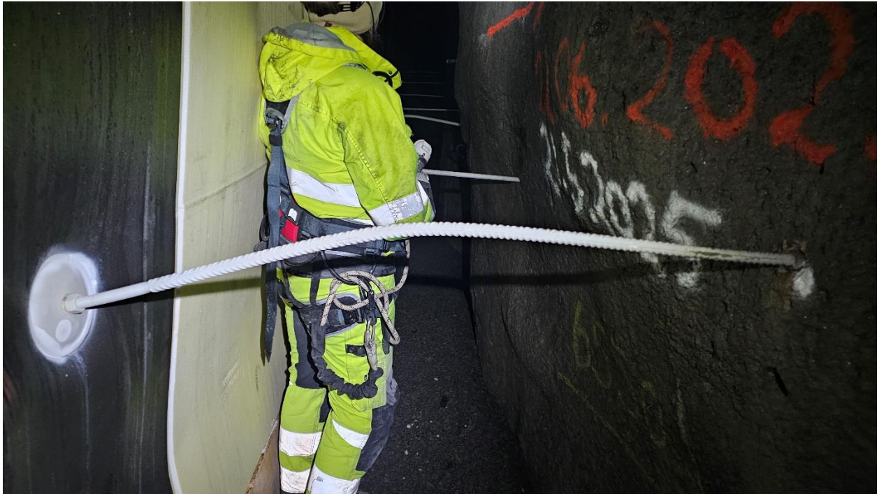
Figur 7. Eksempelbilde for markering av platene med hvit markering og dato med samme farge.
