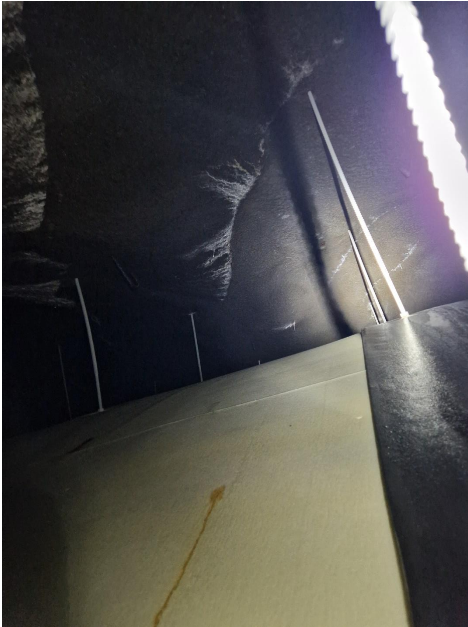
Figur 10. Små riss med kalkutfelling og noe drypp. Tatt fra venstre side ved pel 1040–1050.
